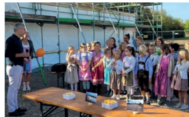
Beim Richtfest des neuen Kinderhauses in Puchheim-Ort
