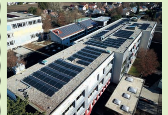
Beispiel Schule am Gernerplatz: Es sollen noch weitere Photovoltaikanlagen auf städtischen Gebäuden folgen
