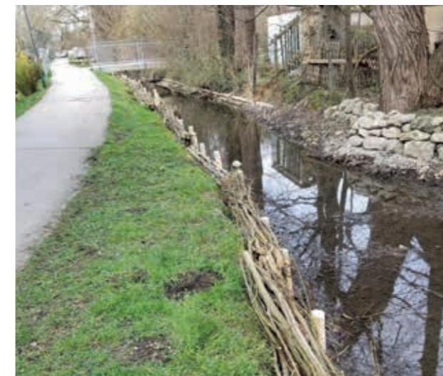
Das sanierte Gröbenbach-Ufer in Puchheim-Ort
